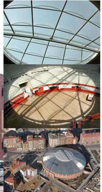
La estructura de la plaza de toros de Aranda de Duero está formada por 36 pórticos metálicos inclinados, dispuestos de forma circular, con un diámetro exterior de 80,00 m y un diámetro interior de 46,00 m.
